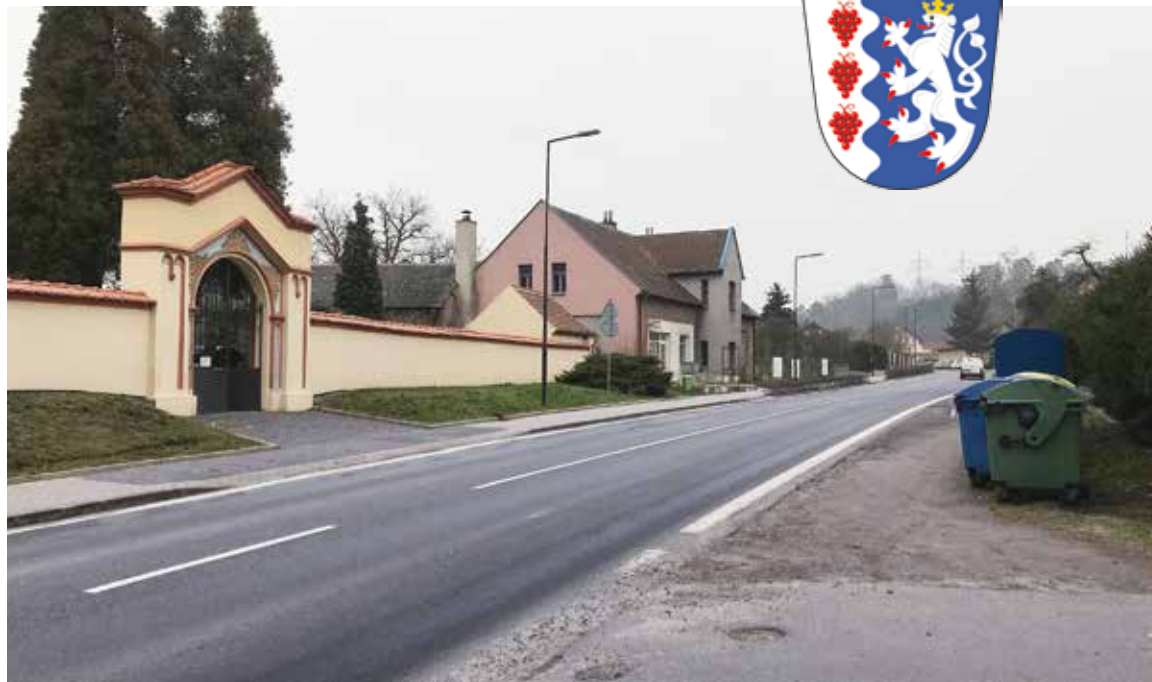
LIBĚCHOV, SILNICE Č. I/9, místo realizace nového přechodu pro chodce u hřbitova.
