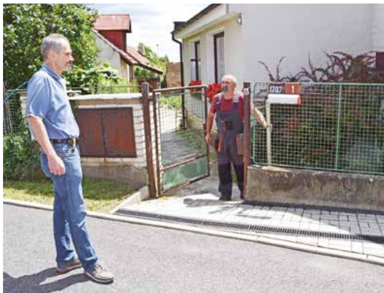
Stav před opravou požadovanou panem Nedvědem
