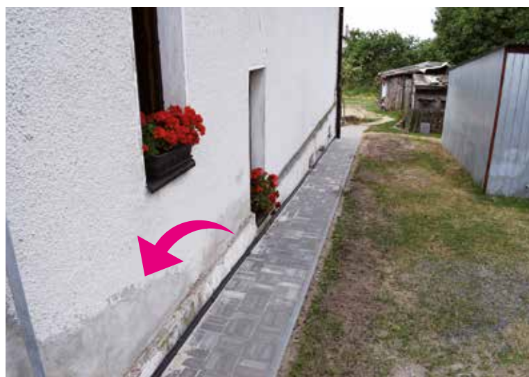
Stav po opravě, kterou provedl pan Nedvěd na vlastní náklady.
