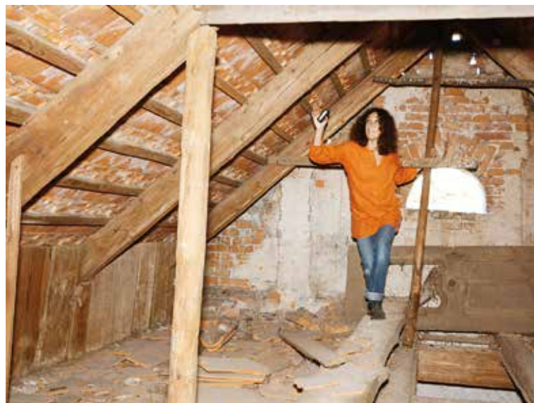
Abigail Rejchrtová kontroluje stav střechy ve mlýně
