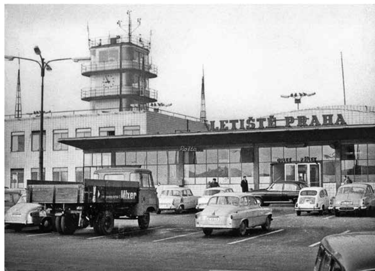
Pohled na terminál na straně k městu ze 60. let dvacátého století
